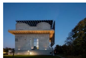
09 Hamburger Energiewerke, Energy Bunker, 2015 © Hamburger Energiewerke/Sumesgutner
